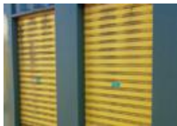
清掃前のシャッター…。
